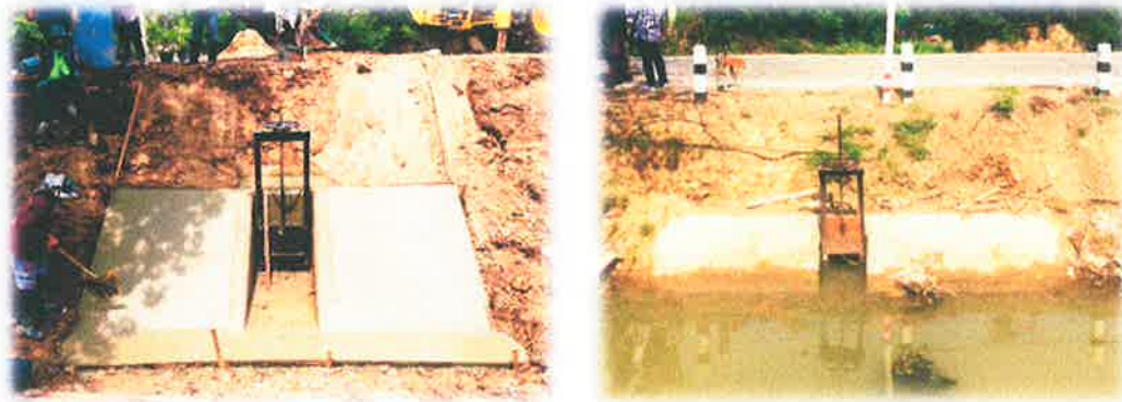
งานปรับปรุงท่อส่งน้ำเข้านาในเขตจัดรูปที่ดินโครงการส่งน้ำและบำรุงรักษาชั้นสูตร จ.อ่างทอง
