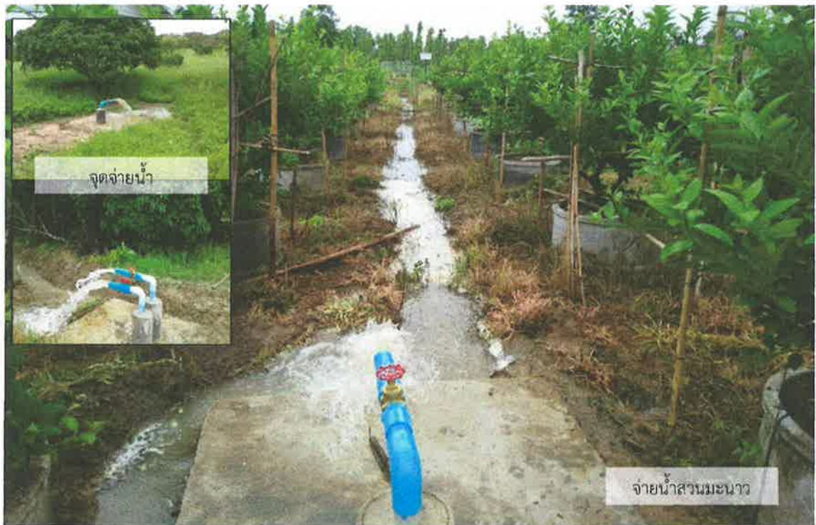
งานก่อสร้างงานจัดระบบน้ำโครงการอ่างเก็บน้ำโป่งจ้อ (ระยะที่ ๒) จ.เชียงใหม่ (๑,๗๓๕ ไร่)
