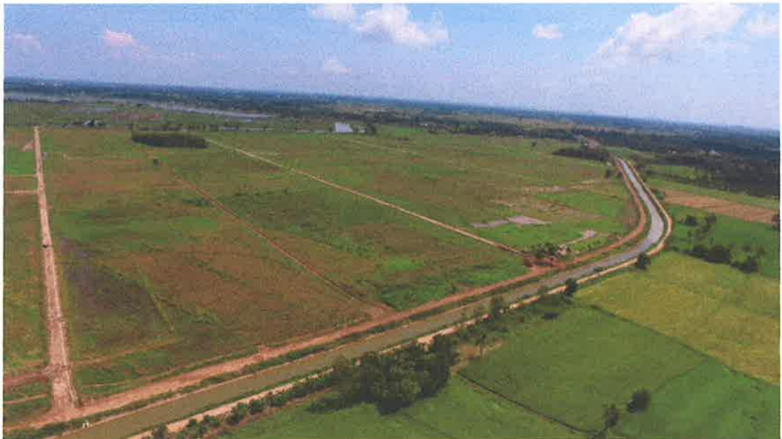
งานก่อสร้างงานจัดรูปที่ดินโครงการส่งน้ำและบำรุงรักษาดงเศรษฐี ต.เมืองเก่า อ.เมืองพิจิตร จ.พิจิตร (๑,๙๕๐ ไร่)
