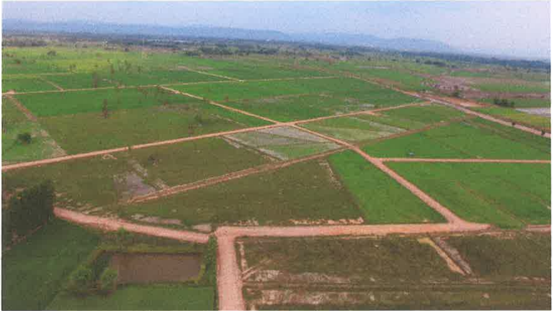
งานก่อสร้างงานจัดรูปที่ดินโครงการส่งน้ำและบำรุงรักษาเขื่อนแควน้อยบำรุงแดน ส่วนที่ ๒๑ ต.หอกลอง อ.พรหมพิราม ต.ท้อแท้ อ.วัดโบสถ์ จ.พิษณุโลก (๑,๑๓๐ ไร่)
