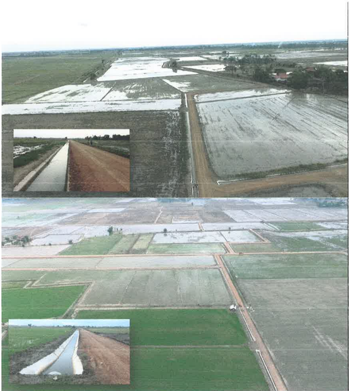
งานก่อสร้างงานจัดรูปที่ดินโครงการส่งน้ำและบำรุงรักษาชั้นสูตร ส่วนที่ ๗ ต.หนองไก่อ ต.คำหยาด อ.โพธิ์ทอง จ.อ่างทอง (๙๘๐ ไร่)
