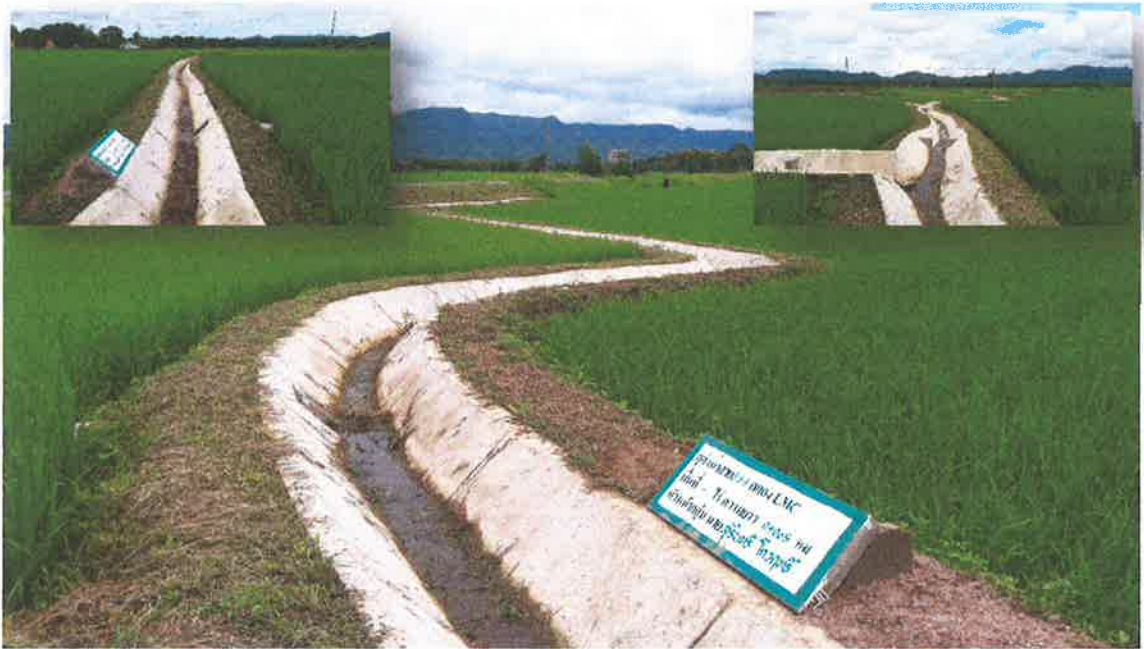
งานก่อสร้างงานจัดระบบน้ำเพื่อเกษตรกรรมโครงการฝายสบึง (ระยะที่ ๑) จ.ลำปาง (๒,๐๔๗ ไร่)
