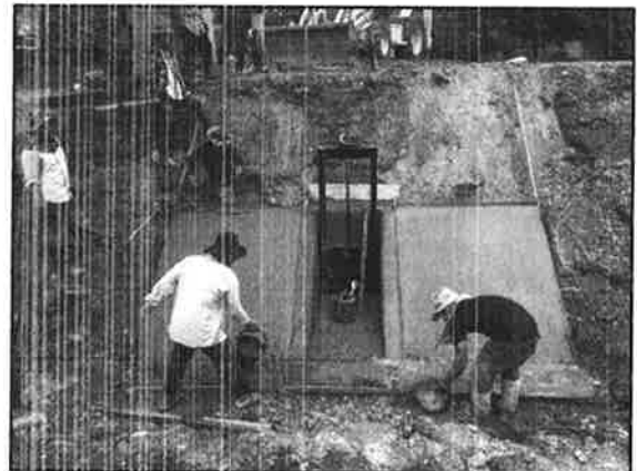
งานปรับปรุงท่อส่งน้ำเข้านา ในเขตจัดรูปที่ดินโครงการส่งน้ำและบำรุงรักษาชั้นสูตร จ. อ่างทอง
