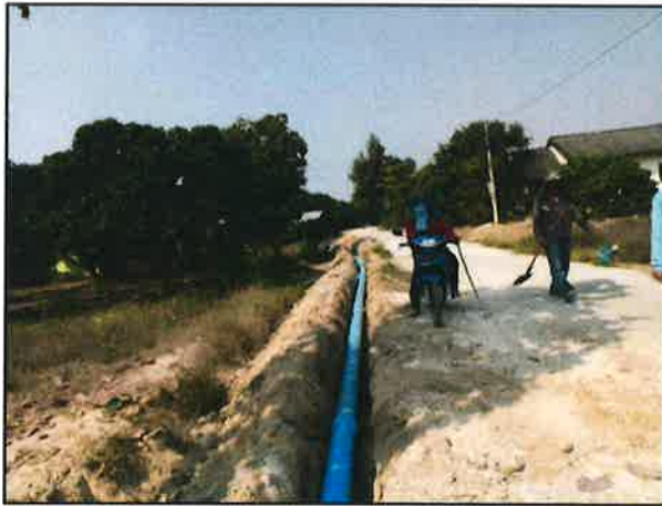
งานจัดระบบน้ำโครงการอ่างเก็บน้ำโป่งจ้อ (ระยะที่ 3) จ.เชียงใหม่
