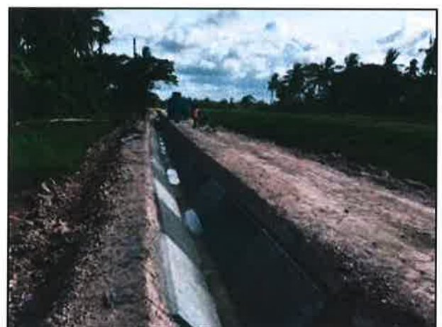
งานจัดระบบน้ำโครงการส่งน้ำและบำรุงรักษาปัตตานี (ตำบลดอนรัก) ระยะที่ 1 จ.ปัตตานี
