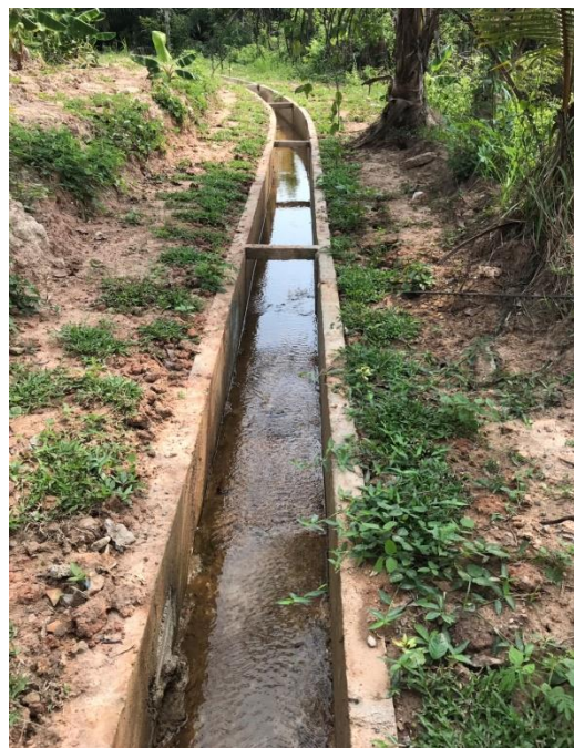
คูส่งน้ำที่ได้รับการปรับปรุงแล้ว U-SHAPE (Cast in Place)
