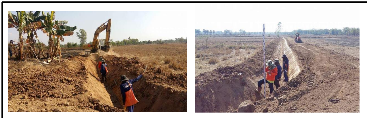
ภาพที่ 13 ภาพประกอบงานขุดคูส่งน้ำ
