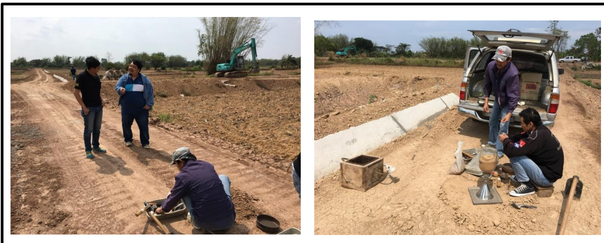
ภาพที่ 15 ภาพประกอบงานทดสอบความแน่นดิน
