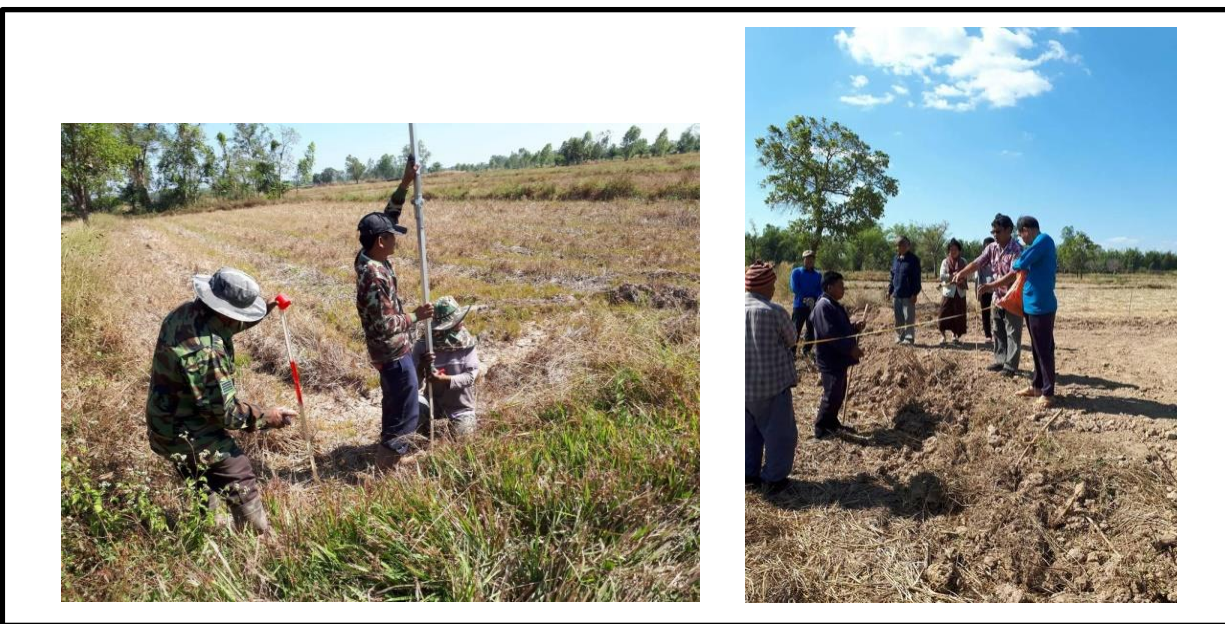
ภาพที่ 10 ภาพประกอบการวางแนวก่อสร้าง
