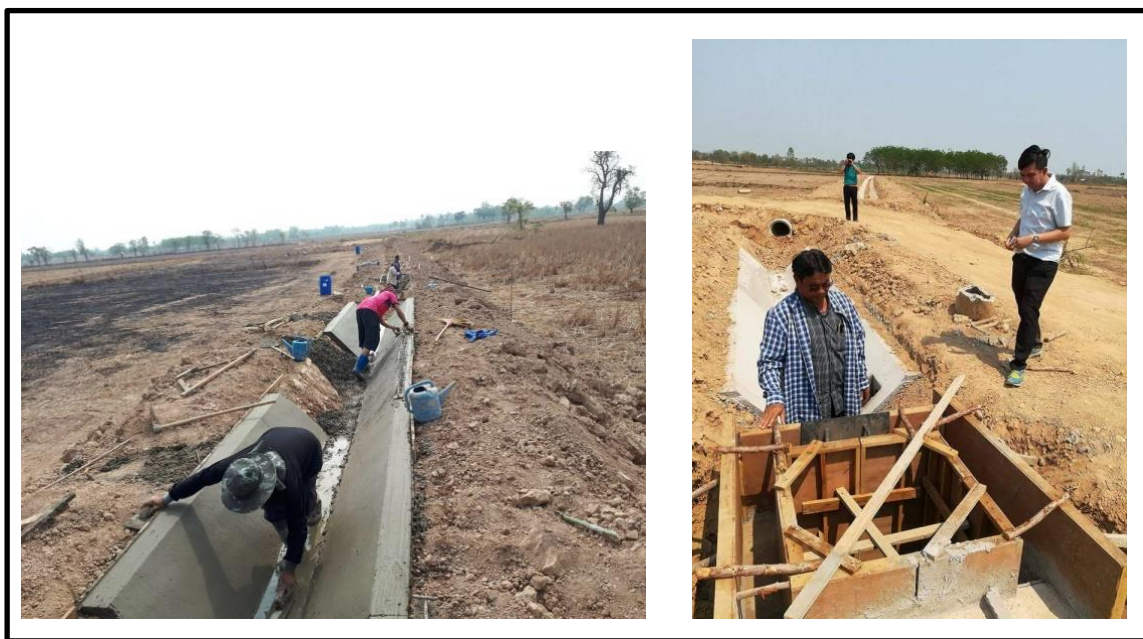
ภาพที่ 14 ภาพประกอบงานขุดคูส่งน้ำ
