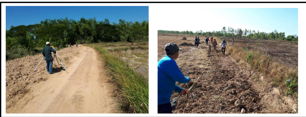
ภาพที่ 9 ภาพประกอบการวางแนวก่อสร้าง
