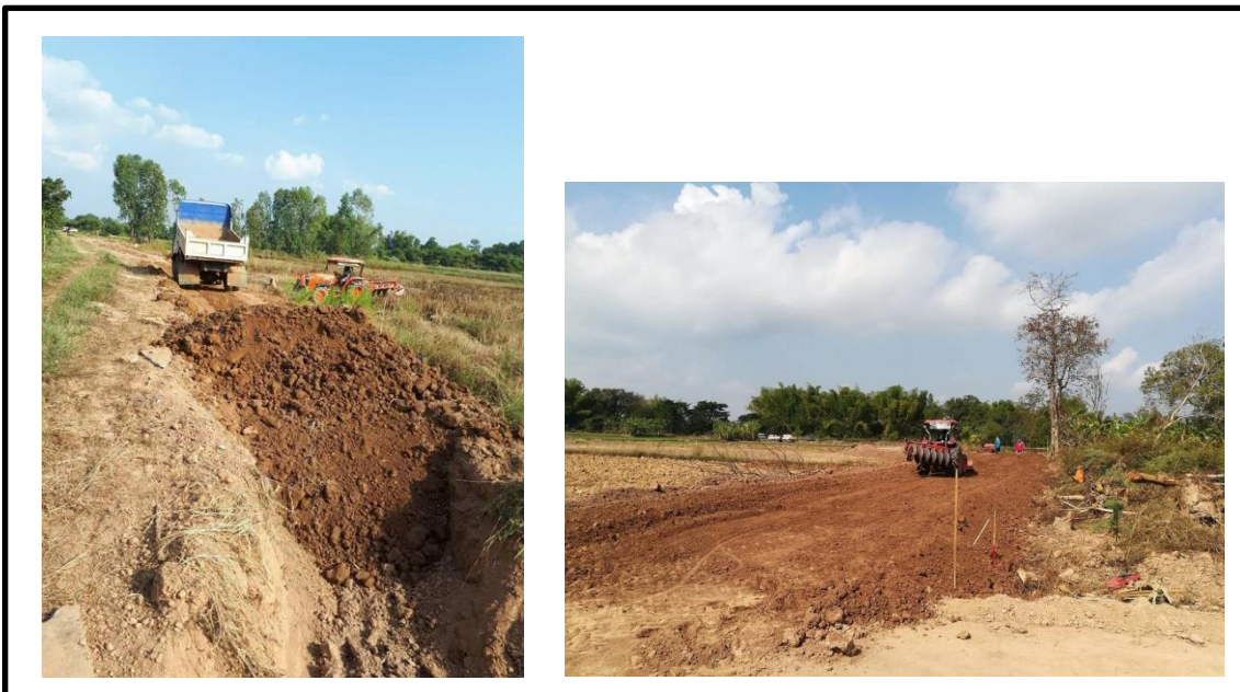
ภาพที่ 12 ภาพประกอบงานถมดินบดอัดแน่น
