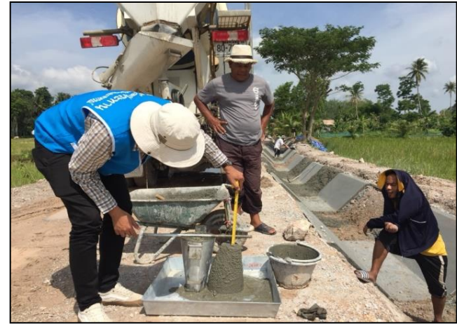
ทดสอบค่ายุบตัวของคอนกรีต (Slump Test)
