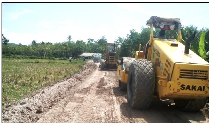
งานดินถมบดอัดแน่นด้วยเครื่องจักร
