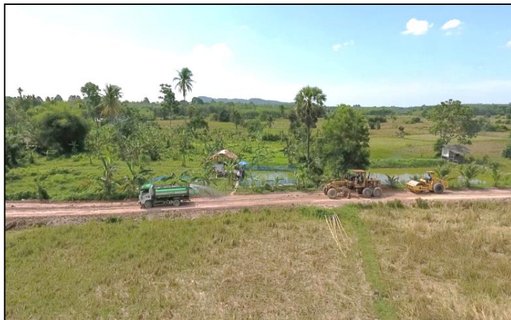
งานดินถมบดอัดแน่นด้วยเครื่องจักร
