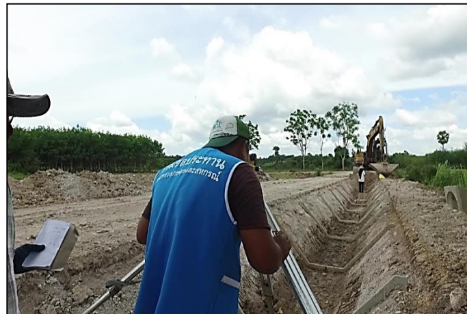
งานตรวจสอบระดับดินขุดท้องคูส่งน้ำ และงานตั้งแบบคาดคอนกรีต
