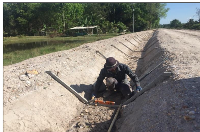
งานตรวจสอบระดับดินขุดท้องคูส่งน้ำ และงานตั้งแบบคาดคอนกรีต
