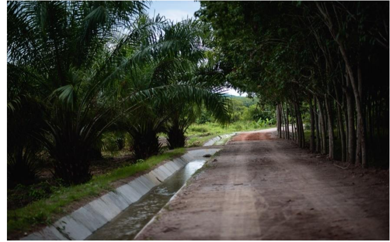
งานคูตาดคอนกรีต ทางลำเลียงและอาคารแผ่นพื้นทางข้าม
