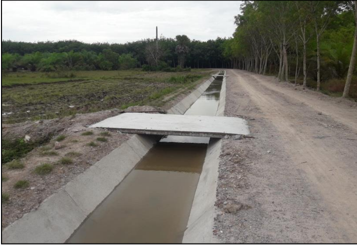
งานคูตาดคอนกรีต ทางลำเลียงและอาคารแผ่นพื้นทางข้าม
