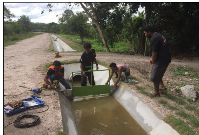
งานปลูกหญ้าและติดตั้งบานเหล็กอาคารประกอบ
