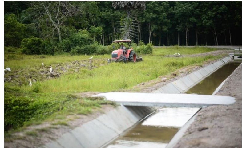
งานคูตาดคอนกรีต ทางลำเลียงและอาคารแผ่นพื้นทางข้าม
