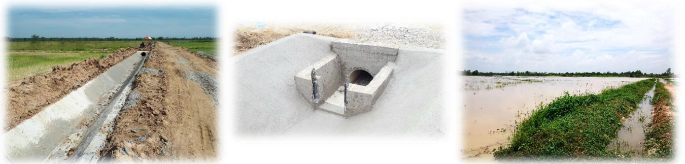
งานจัดรูปที่ดินโครงการส่งน้ำและบำรุงรักษาลำปาว ระยะที่ ๒ จ.กาฬสินธุ์
