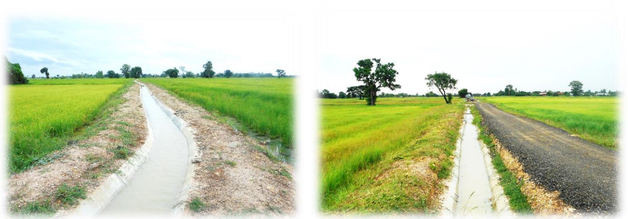
งานจัดรูปที่ดินโครงการอ่างเก็บน้ำห้วยสวาย (ส่วนที่ ๓) จ.บุรีรัมย์
