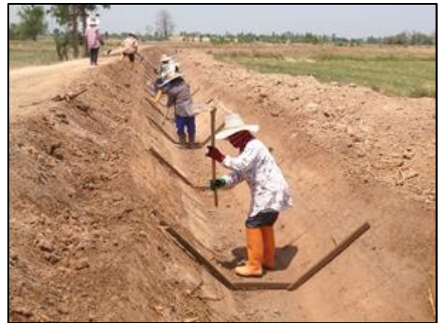
งานจัดระบบน้ำโครงการชลประทานชัยนาท ส่วนที่ 1 จ.ชัยนาท
