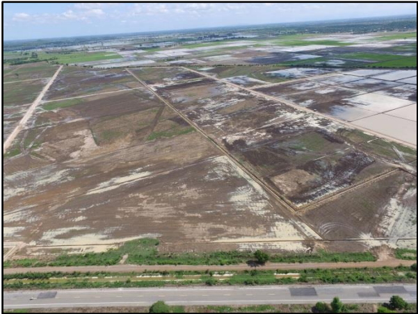
งานจัดรูปที่ดินโครงการส่งน้ำและบำรุงรักษาท่าโบสถ์ ส่วนที่ 3 จ.สุพรรณบุรี
