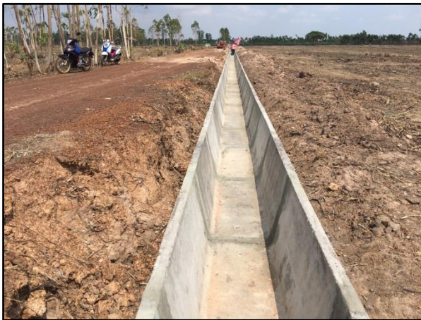
งานจัดระบบน้ำสถานีสูบน้ำ P6B (ระยะที่ 2) จ.อุดรธานี
