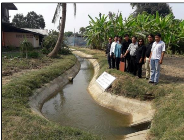
งานจัดระบบน้ำโครงการส่งน้ำและบำรุงรักษานครปฐม (คลอง 2R-5L ระยะ2) จ.ราชบุรี
