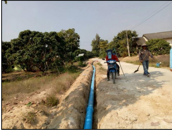
งานจัดระบบน้ำโครงการอ่างเก็บน้ำโป่งจ้อ (ระยะที่ 3) จ.เชียงใหม่
